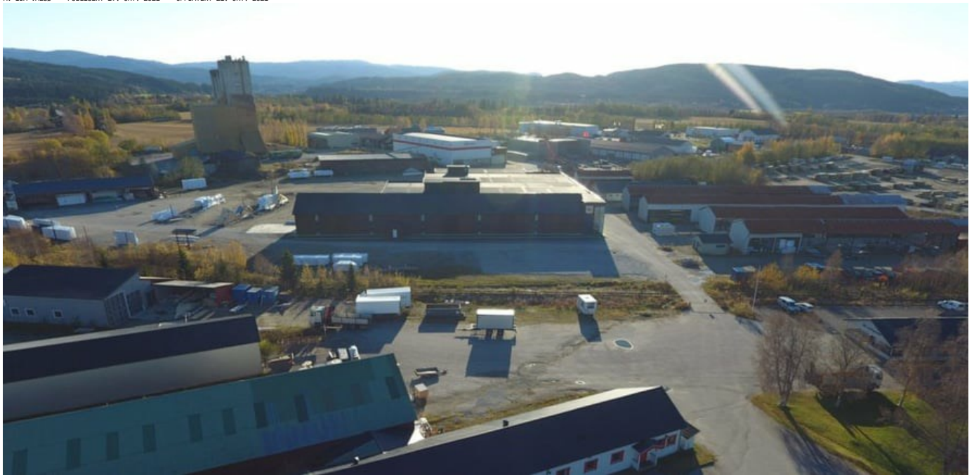
Skogmo Industripark i Namdalen. Foto: Skogmo Industripark.
