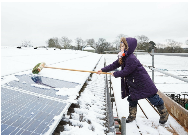
Når anlegg som det på bildet er dekket av snø, kan stående solcelleanlegg fortsatt produsere energi. (Foto: G. Hagedorn/Wikimedia commons)
