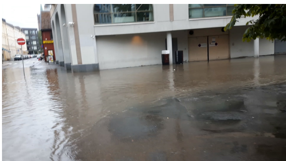
Da Tøyenbekken nådde Nordbygata. Foto: Oslo kommune
