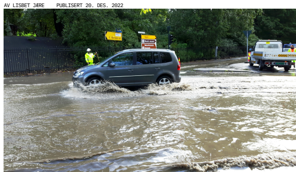
Oversvømmelse etter ekstremnedbør på Tøyen i Oslo. Foto: Oslo kommune
