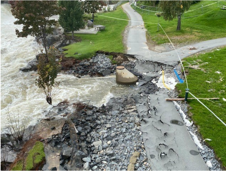
FLOMSKADER: Her har Hønefossen gjort innhugg i landskapet etter store nedbørsmengder i 2023. (Foto: Anne solheim)
