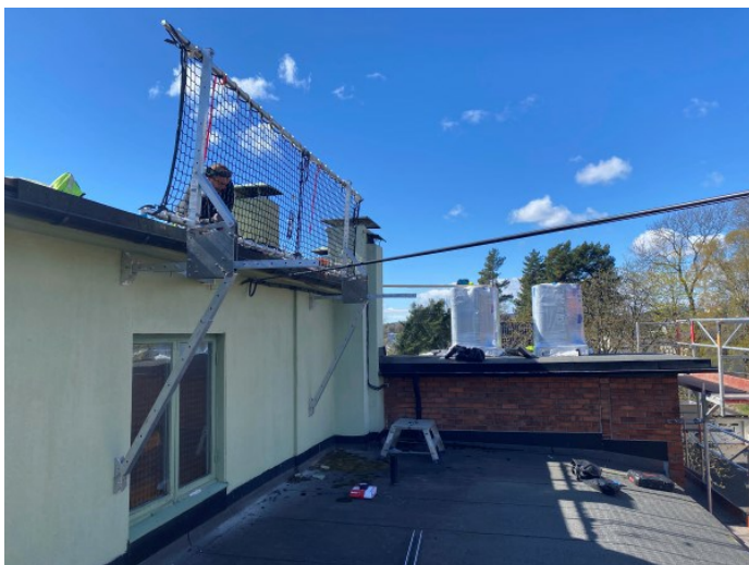
Storo Blikkenslagerverksted har deltatt i forskningsprosjektet med utprøving av ny taksikring under faktisk arbeid. (Foto: Safedesign)
