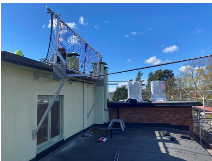
Storo Blikkenslagerverksted har deltatt i forskningsprosjektet med utprøving av ny taksikring under faktisk arbeid. (Foto: Safedesign)
