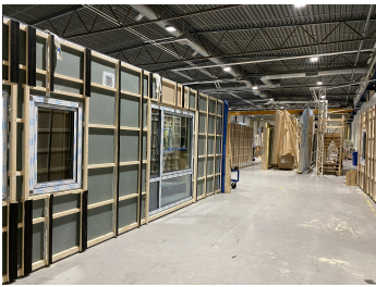
På Frekhaug nord for Bergen prefabrikerer Norske Elementfabrikker veggelementer i tre. Foto: Håkon Kalbakk.
